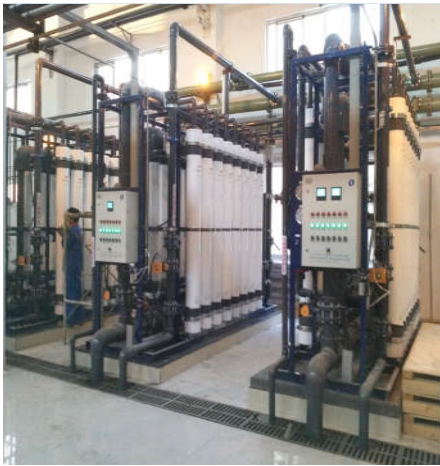
膜法系统在焦化废水回用的挑战：高 COD、高含盐量、系统回收率 70%
